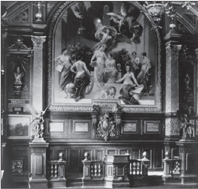
Abb. 27: Das Innere der Aula (zerstört 1944), Blick auf die Westwand
