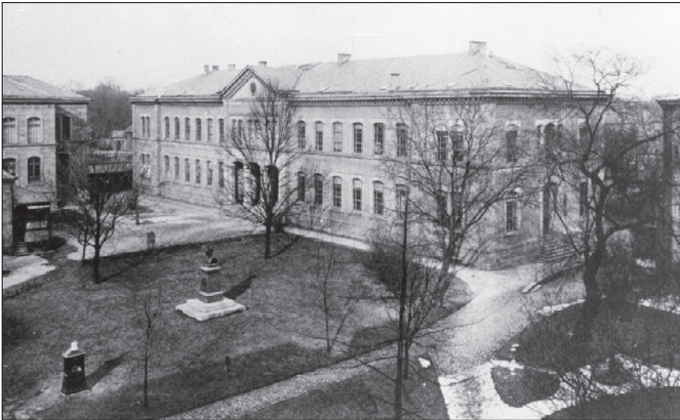
Abb. 8: Das Maschinenbaugebäude, fertiggestellt 1859, Aufnahme ca. 1890
