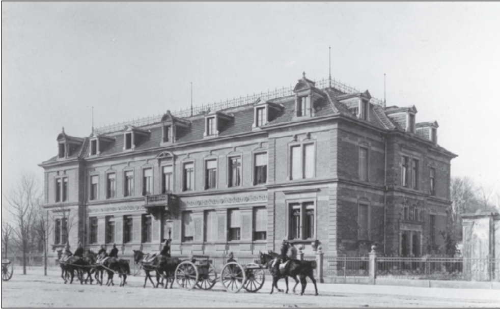
Abb. 25: Das Botanische Institut am Durlacher Tor; fertiggestellt 1899, Aufnahme von 1900
